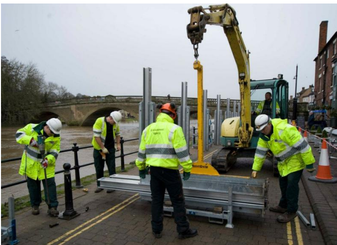
Kuva 54. Tilapäinen tulvaseinä suojaa asutusta Severn-joen tulvalta Iso-Britaniassa keväällä 2014. (©Environment Agency)
