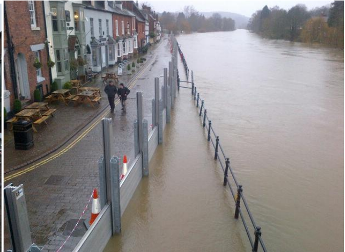
Kuva 54. Tilapäinen tulvaseinä suojaa asutusta Severn-joen tulvalta Iso-Britaniassa keväällä 2014. (©Environment Agency)
