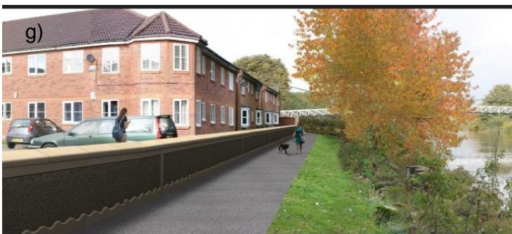
Kuva 50. Tulvasuojausesimerkkejä Suomesta ja muualta Euroopasta. (© Environment Agency 2009; Rautio 2014) a–b) Tulvaseinien toteutuksen ja maisemoinnin eri materiaali- ja toteutusmahdollisuuksia (Nivalassa kuva a, Iso-Britanniassa kuva b), c) Kiinteisiin perustuksiin pystytettävä tulvaseinä. d) Maisemoitu, tarvittaessa käytettävä tulvaseinä joen varressa. e–g) Erilaisia tulvapengerratkaisuja: tulvaseinä ja tulvapenger voidaan yhdistää tilan säästämiseksi (e), tulvapenkereitä tarvittaessa korottaa lankuilla (Jalasjärvi) (f) ja tulvapenkereitä käytetään myös virkistysalueina (g). h) Kiinteäperustaisen tai kiinteän tulvaseinän rakennettuna joen rannan myötäiseksi suurempia alueita suojaavaksi rakenteeksi.
