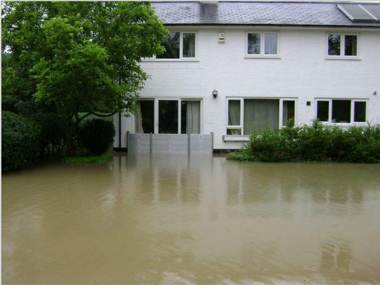
Kuva 56. Esimerkki ovien ja ikkunoiden tulvasuojauksesta Iso-Britanian talven 2013—2014 tulvassa. (©Environment Agency).
