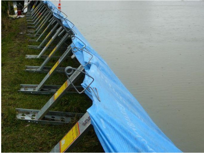
Kuva 53. Erilaisia Geodesign Barrier -tulvaseiniä. (©Hydro Response Ltd).
