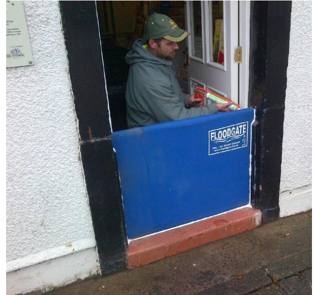
Kuva 56. Esimerkki ovien ja ikkunoiden tulvasuojauksesta Iso-Britanian talven 2013—2014 tulvassa. (©Environment Agency).
