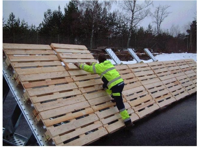
Kuva 53. Erilaisia Geodesign Barrier -tulvaseiniä. (©Hydro Response Ltd).
