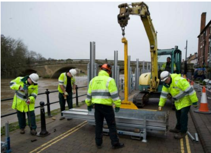
Kuva 60. Tilapäinen tulvaseinä suojaa asutusta Severn-joen tulvalta Iso-Britanniassa keväällä 2014. (©Environment Agency)
