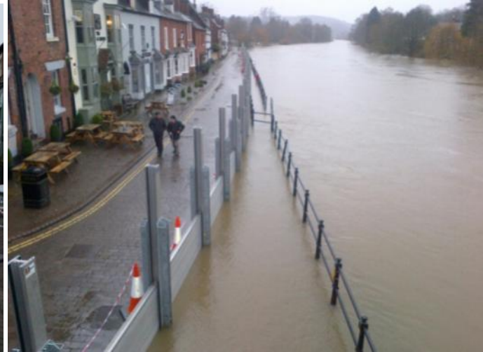
Kuva 60. Tilapäinen tulvaseinä suojaa asutusta Severn-joen tulvalta Iso-Britanniassa keväällä 2014. (©Environment Agency)
