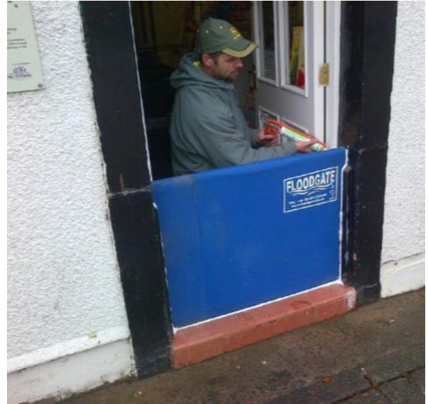
Kuva 62. Esimerkki ovien ja ikkunoiden tulvasuojauksesta Iso-Britanian talven 2013—2014 tulvassa. (©Environment Agency).
