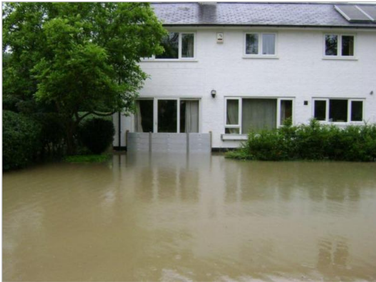
Kuva 62. Esimerkki ovien ja ikkunoiden tulvasuojauksesta Iso-Britanian talven 2013—2014 tulvassa. (©Environment Agency).
