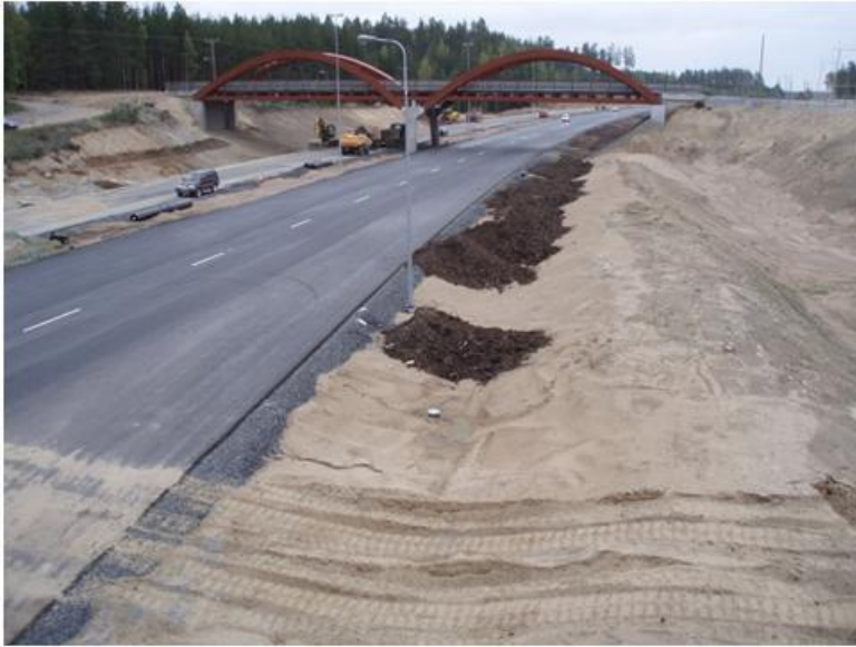
Kuva 15.2. Pohjavesisuojausten rakentaminen Ylöjärvenharjulla (kuva Vesa Hyvärinen).
