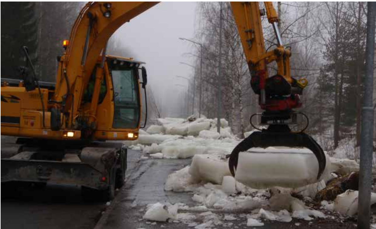
Kuva 10.2. Jään poistoa Vantaanjoesta ennen kevättulvaa. (Riihimäen kaupunki 2011)
