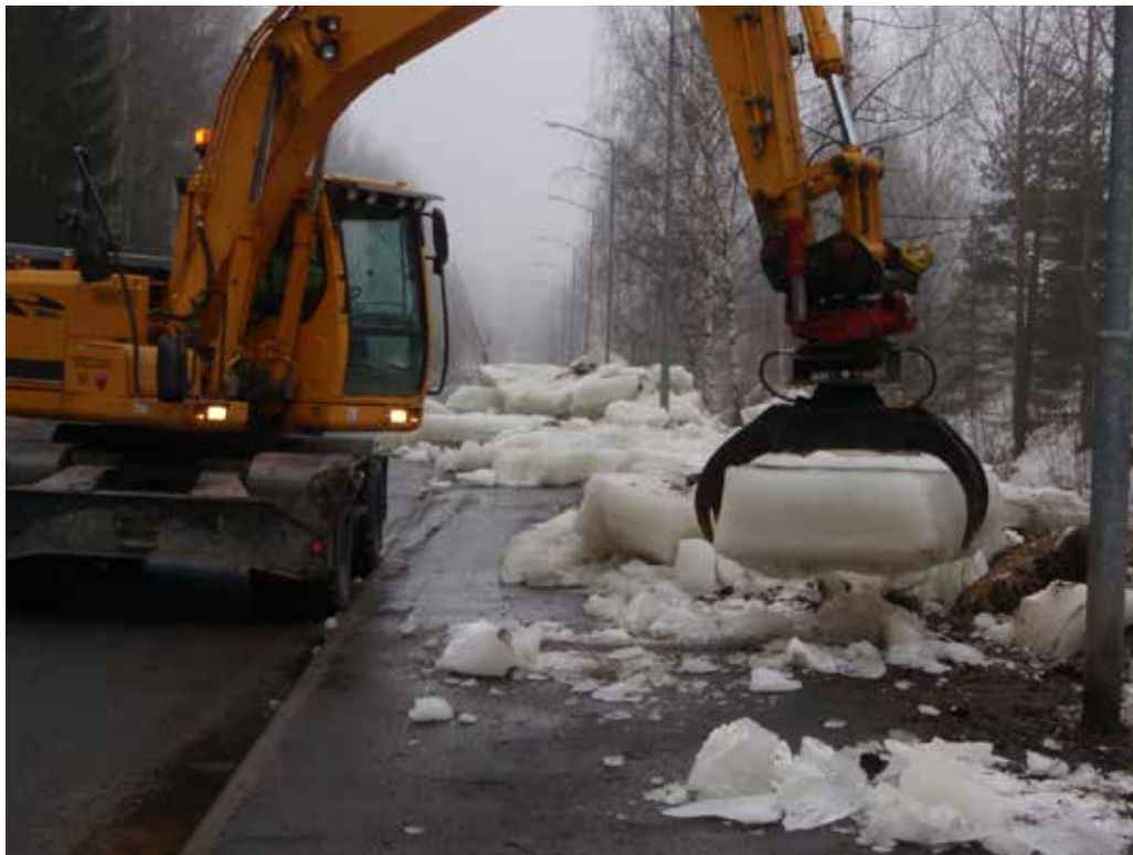
Kuva 5. Jään poistoa Vantaanjoesta ennen kevättulvaa. (Riihimäen kaupunki 2011)
