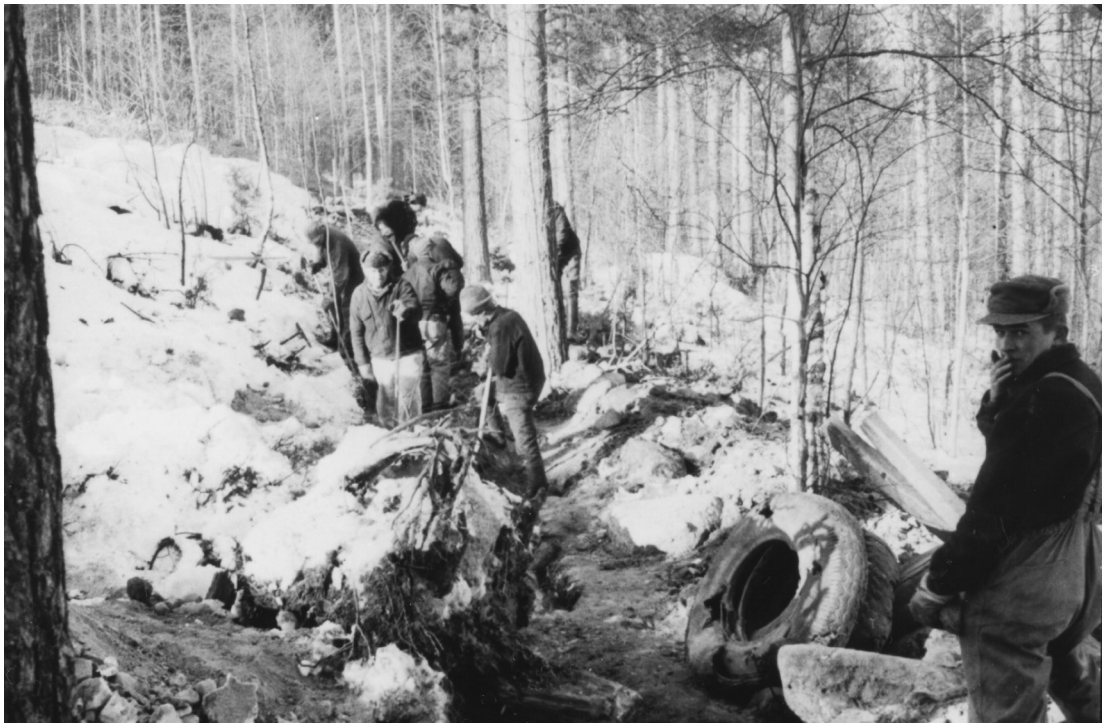
Vesijohdon kaivuutyömaa keväällä 1954 Herajärven pumppaamolta ylävesisäiliölle (Kuva: Saarijärven Museo)
