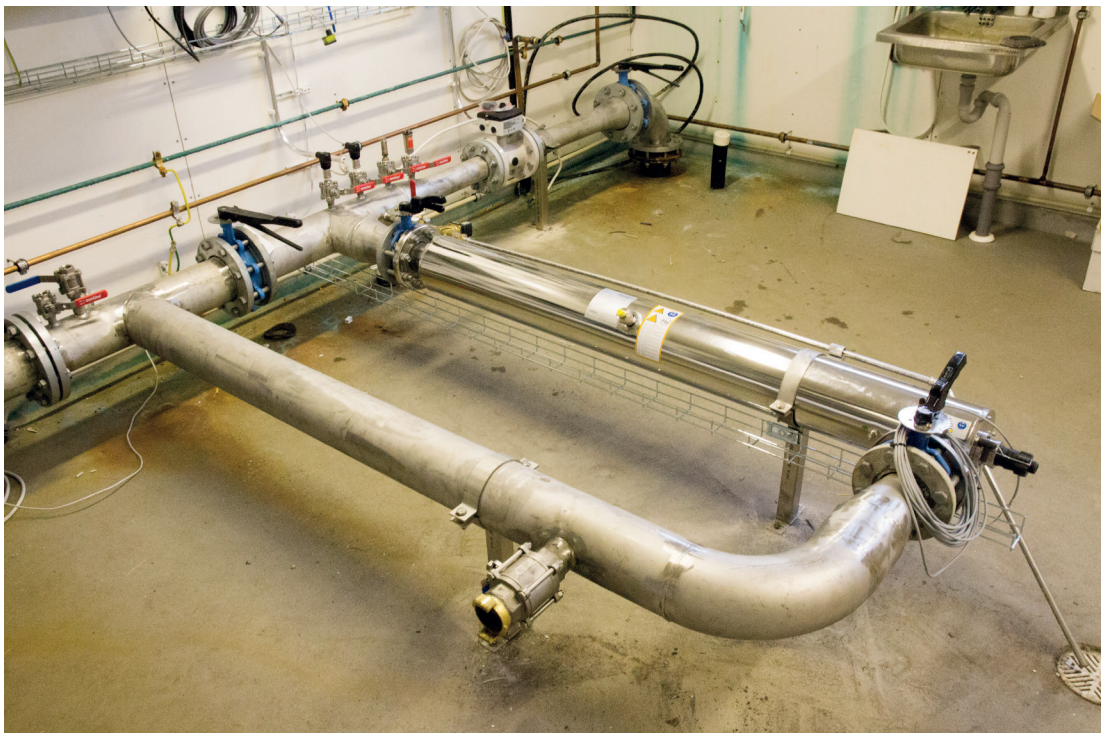
Kopanniemen vedenottamon saneeraus, ottamolle uusittiin putkistoa ja laitteistoa sekä lisättiin UV-desinfiointilaitteisto (Kuva: Saarijärven Vesihuolto Oy, kuvaaja Tuomo Vilkkilä 2015)
