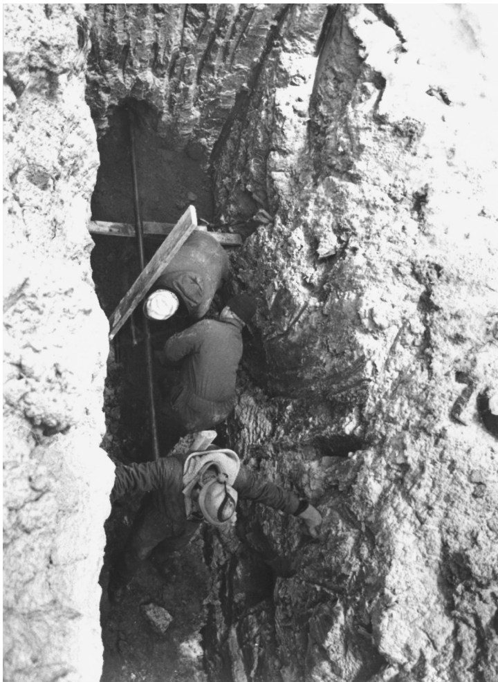
Tienalitus poraus "vanhalla" menetelmällä Rahkolassa maaliskuussa 1986 (Kuva: Saarijärven Vesihuolto Oy)
