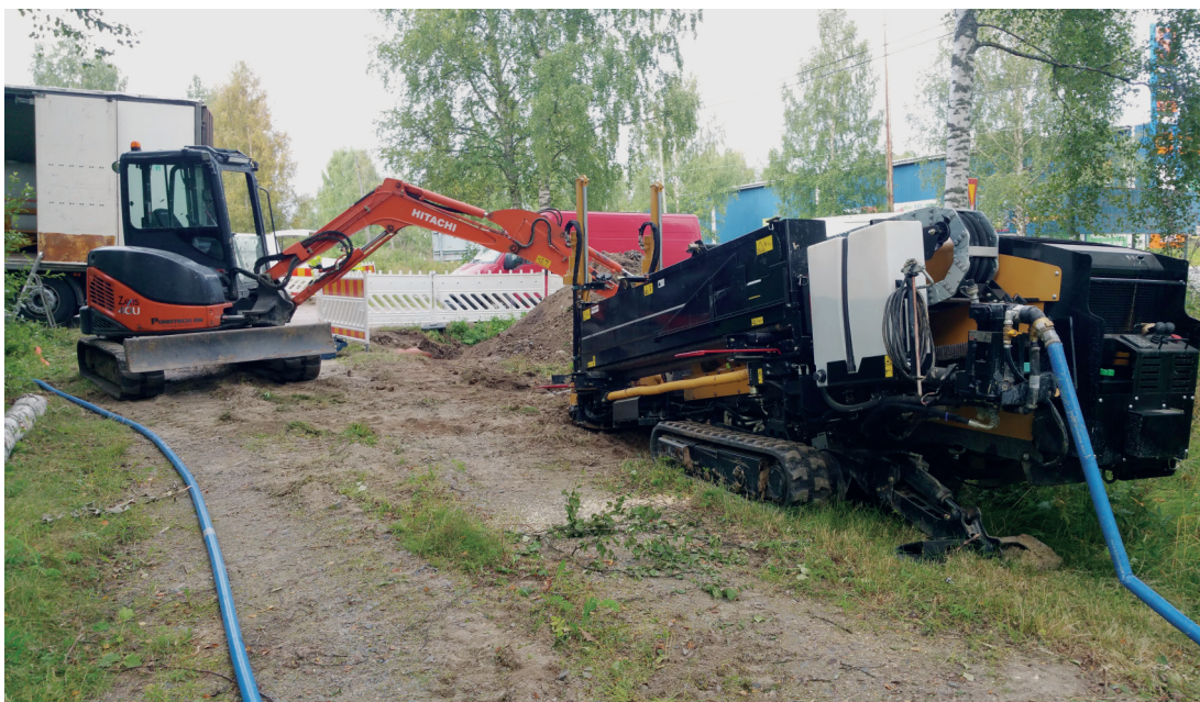
Kunniavuorentien alitus suuntaporalla nykytekniikalla kesällä 2016 (Kuva: Saarijärven Vesihuolto Oy, kuvaaja Tuomo Vilkkilä)
