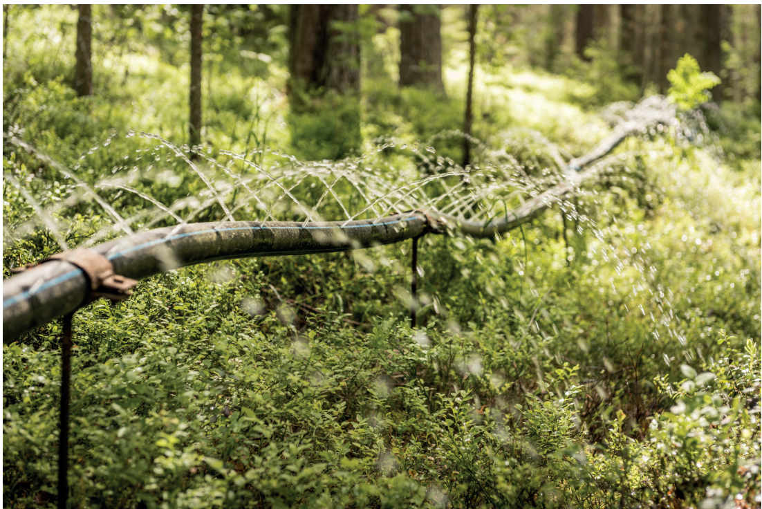
Mannilan harjun tekopohjaveden sadetusputki (Kuva: Saarijärven Vesihuolto Oy, kuvaaja Mikko Suutala 2015)
