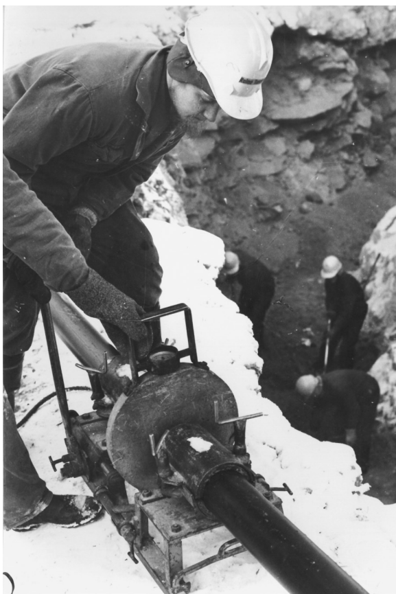
Vuonna 1977, Raimo Tuominen tekemässä vesijohdon puskuhitsausta (Kuva: Saarijärven Vesihuolto Oy)
