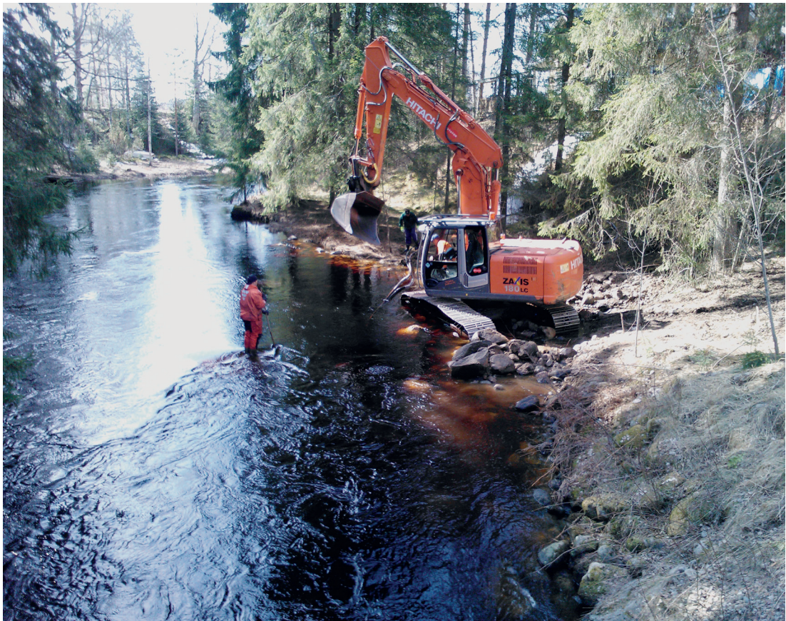
Vesiosuuskunta Lanneveden vesi- ja viemärijohtotyö Lannejoessa (Kuva: Saarijärven Vesihuolto Oy, kuvaaja Timo Lehtonen 2013)
